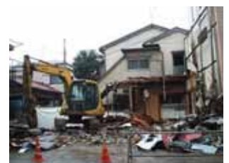
雨の中の解体作業
