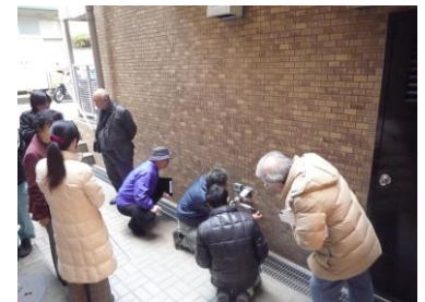
タイルの付着力検査をしています
